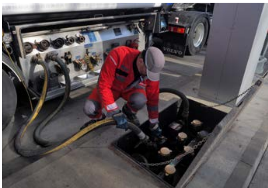
Při stáčení je kolem stáčecího místa ochranná zóna v okruhu 3 m, ve které smí být pouze řidič vybavený ochrannými pomůckami
