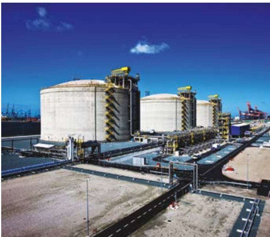
LNG Terminal Hammerfest Norsko 2.
