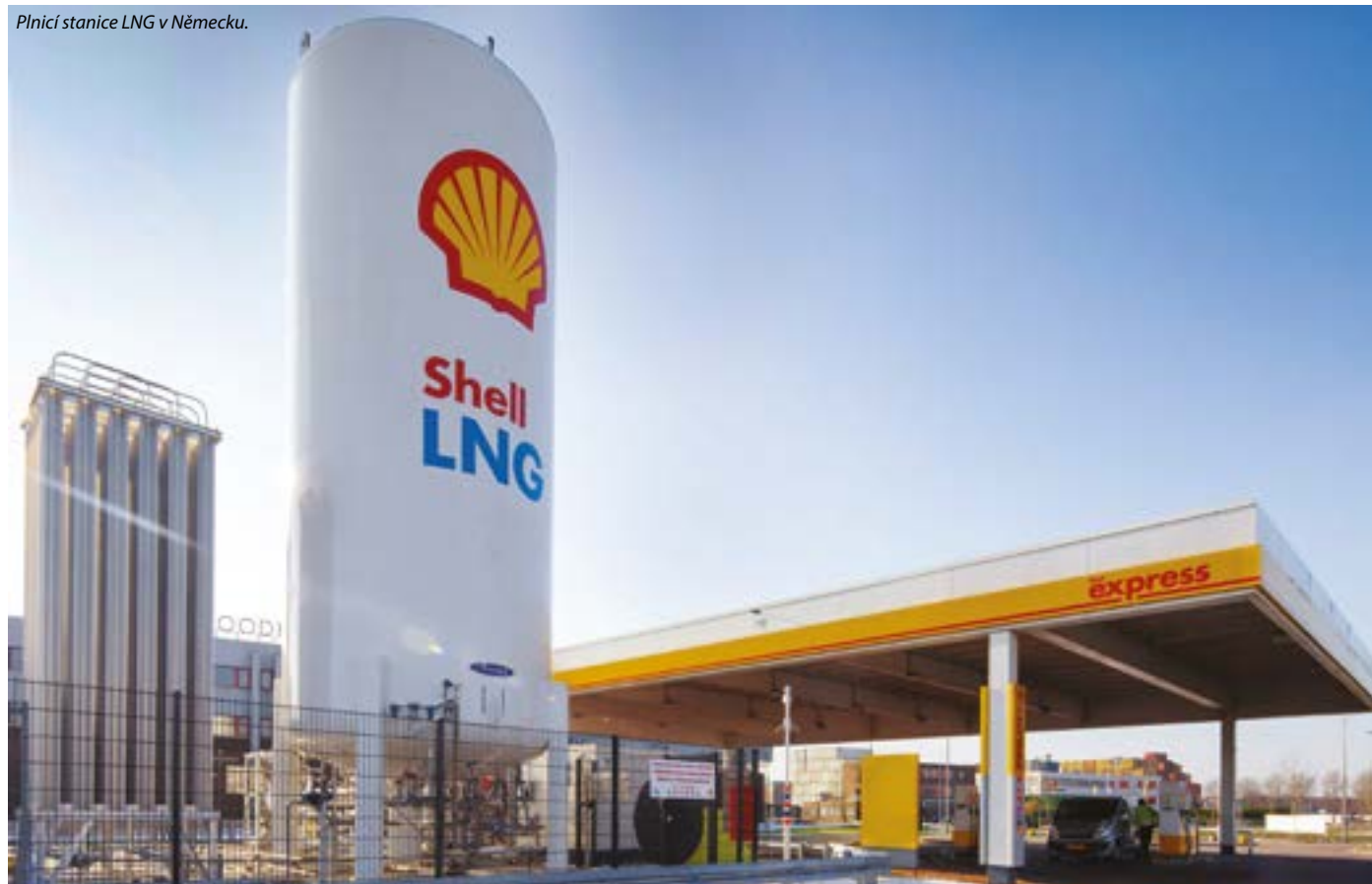
Plnicí stanice LNG v Německu.
